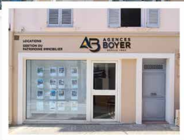
Façade Gérance et Location
